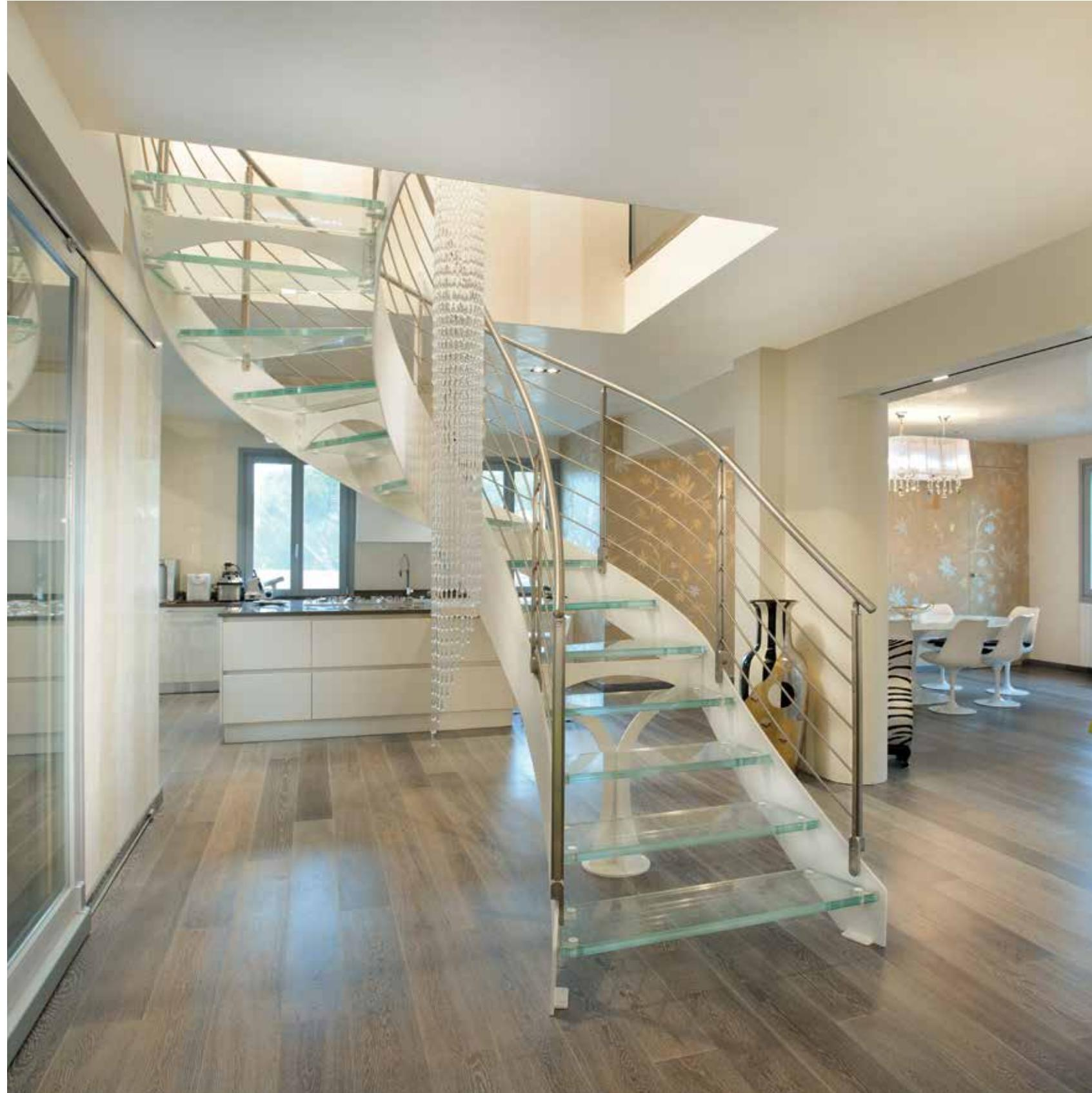
Scala elicoidale modulare con doppia struttura laterale a fascia in acciaio inox e gradini in cristallo temperato stratificato extra-chiaro, con soppalco in cristallo temperato stratificato e acciaio inox.
