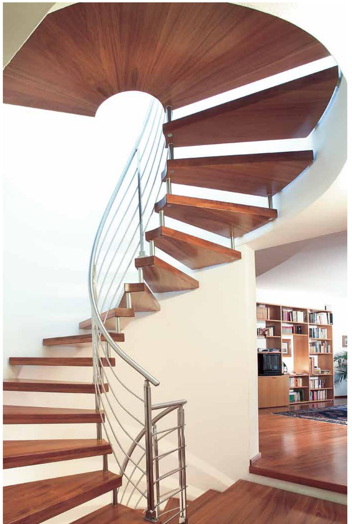
Scala elicoidale a sbalzo a giorno in doussiè massello con ringhiera a tondini orizzontali in acciaio inox.
