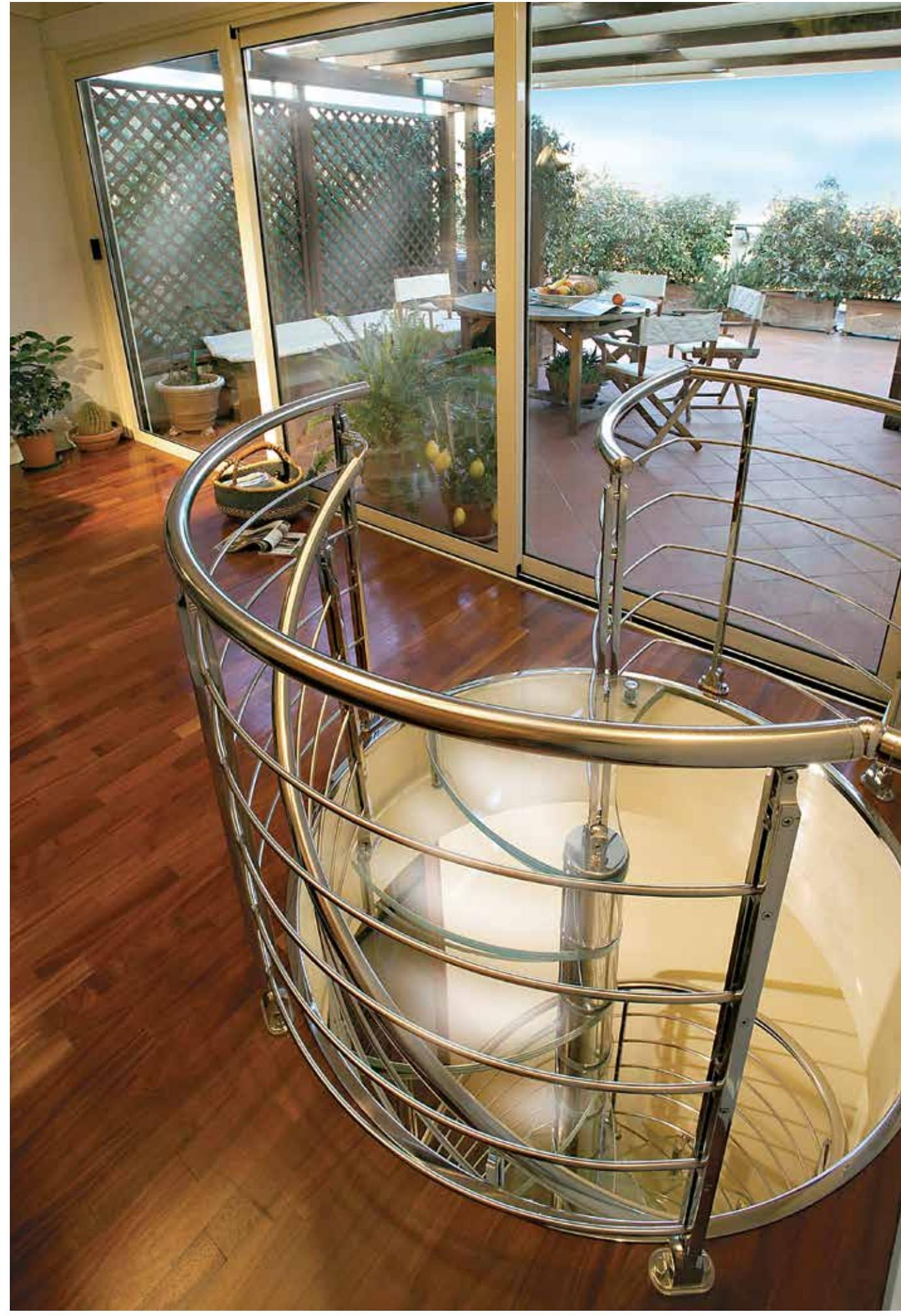
Scala a chiocciola con gradini in cristallo strutturale extrachiaro e ringhiera a tondini orizzontali in acciaio inox.
