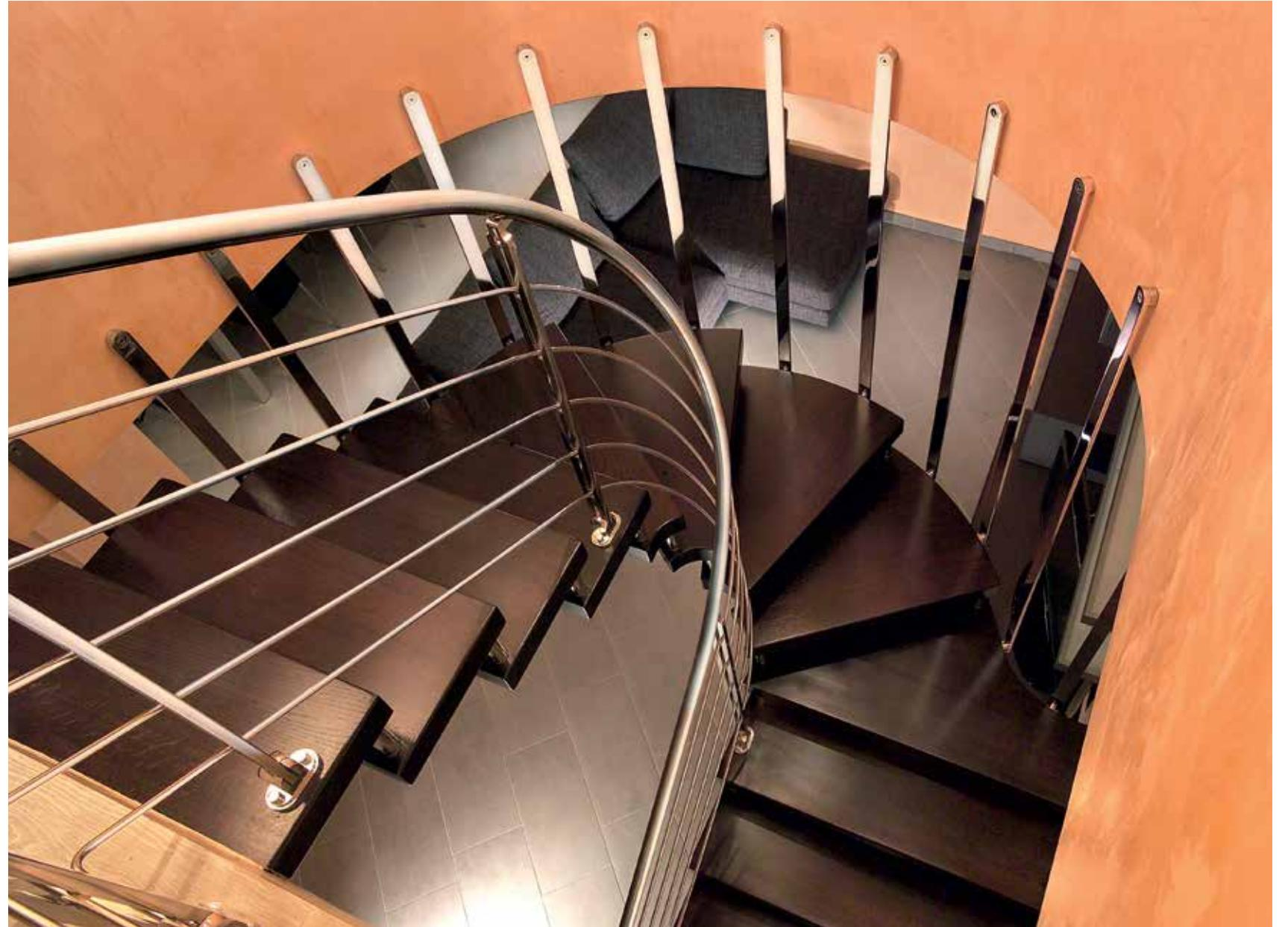
Scala a sbalzo a giorno ancorata al solaio con scalino in massello di rovere con finiture wengé e ringhiera a tondini orizzontali in acciaio inox.
