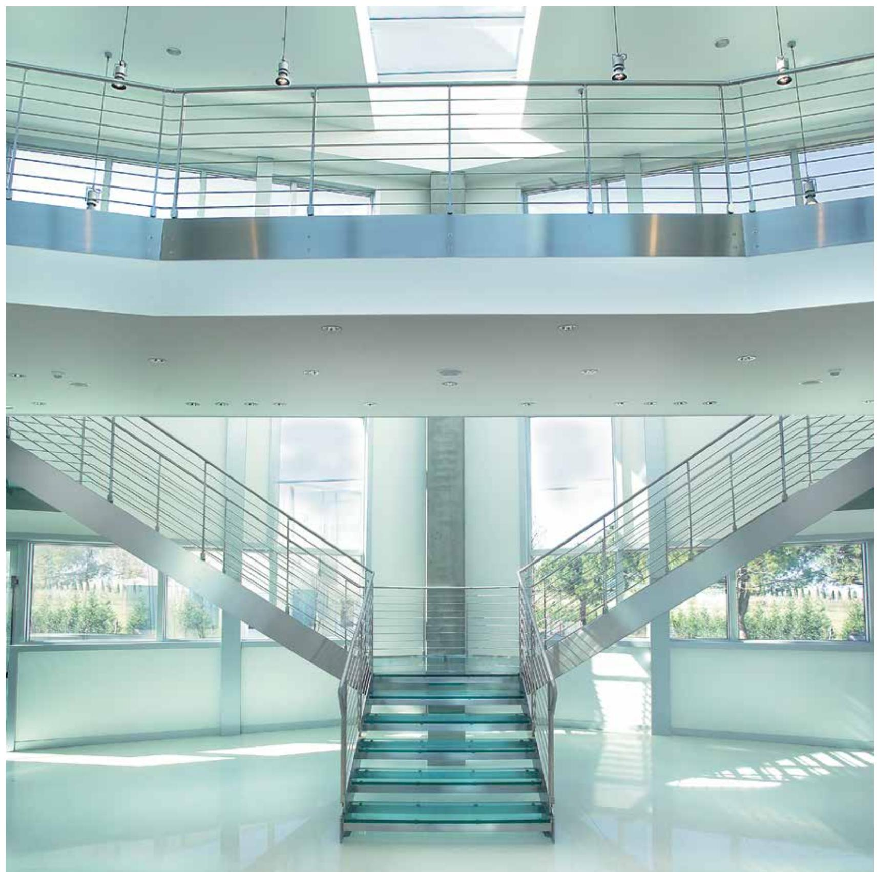
Scale a giorno con strutture a fascioni laterali in acciaio inox con gradini in cristallo float stratificato e ringhiera in acciaio inox a tondini orizzontali.
