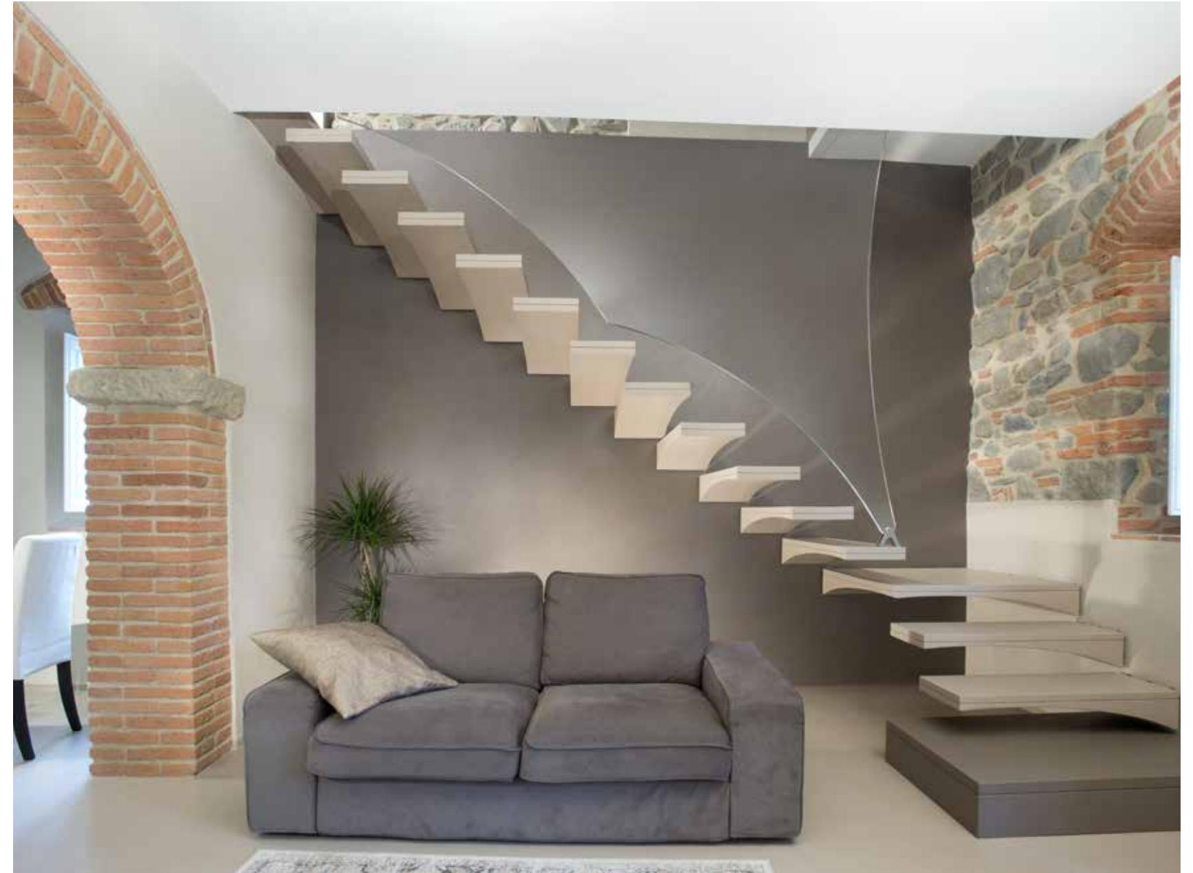
Scal a sbalzo con gradini rivestiti in corian e inserto in acciaio inox con texture e ringhiera in cristallo temperato extra chiaro.
