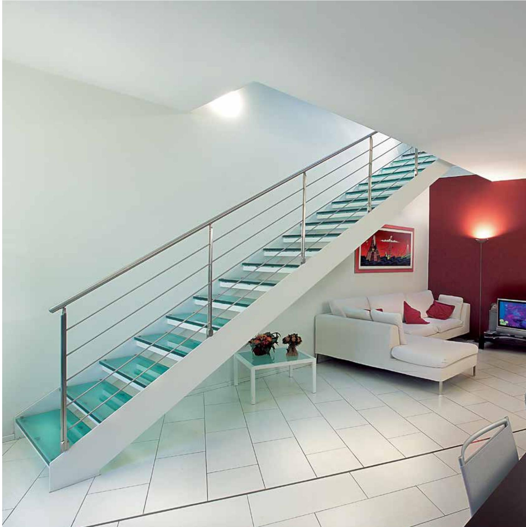
Struttura laterale a fascia in acciaio verniciato con gradini in cristallo stratificato satinato e ringhiera in acciaio inox a tondini orizzontali.
