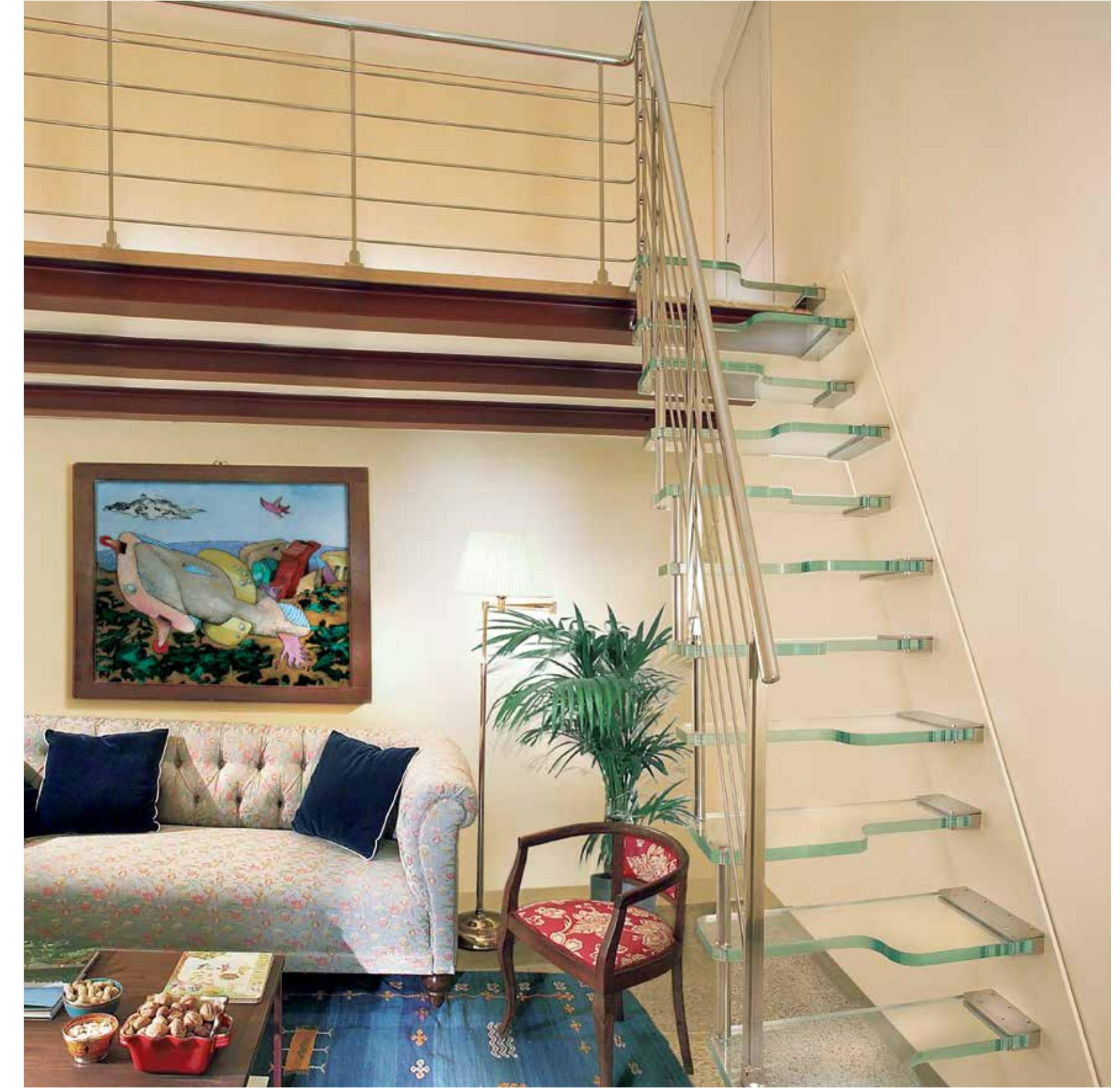
Scala a sbalzo chiusa con gradini e sottogrado in acciaio inox, con ringhiera in cristallo strutturale extrachiaro.
