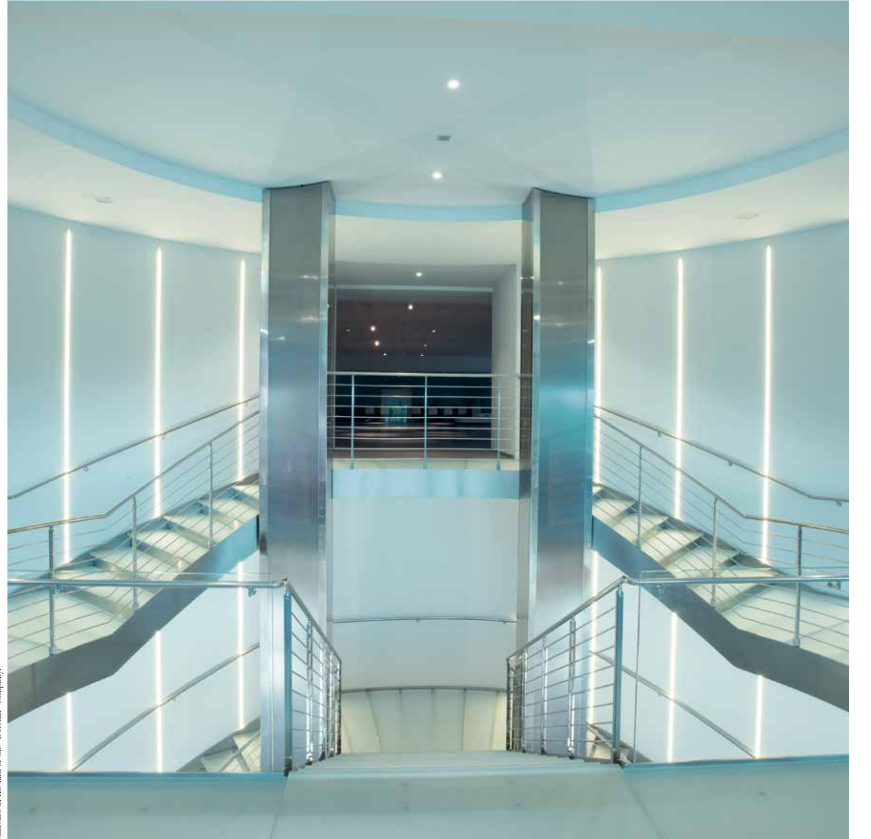
Scalare con alzata e struttura a fascioni laterali in acciaio inox con gradini in cristallo stratificato satinato antiscivolo e ringhiera in acciaio inox a otto tondini.
